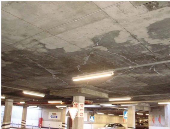
Рис. 12. Сквозные трещины в железобетонном перекрытии НМРА
