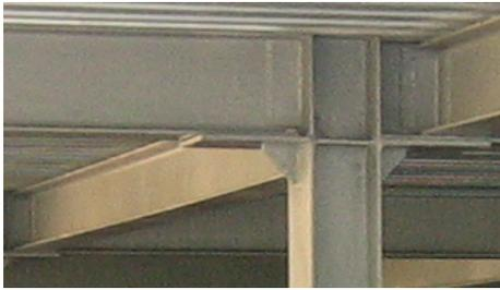
Рис. 5а. Сварные балочно-стоечные сопряжения
