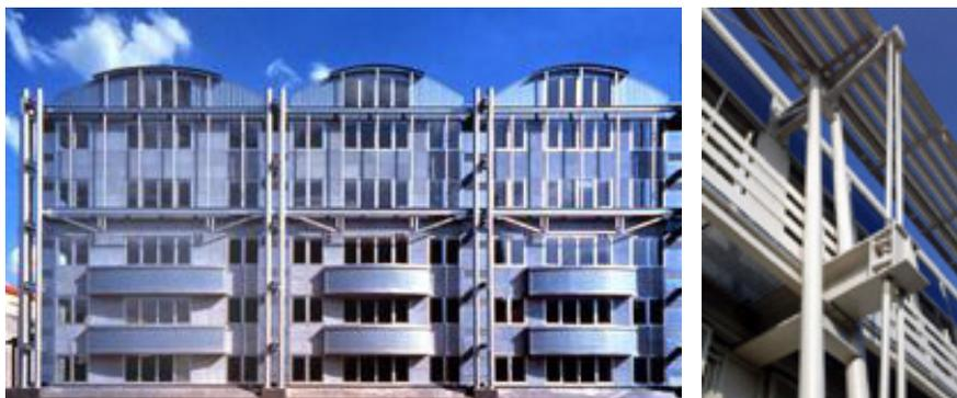
Переменный размер поперечных сечений может придать определенный архитектурный динамизм внешнему облику таких колонн, состоящих из стандартных прокатных профилей или пластин. Характерной особенностью является то, что размер поперечного сечения изменяется по длине колонны, что также способствует повышению эффективности работы конструкции.
