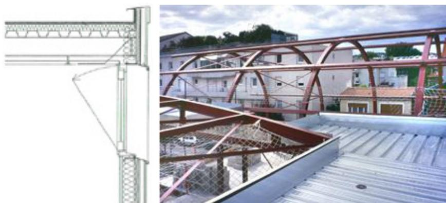
Рисунок 5.13. Узел сопряжения фасада и кровли – вид в процессе строительства
