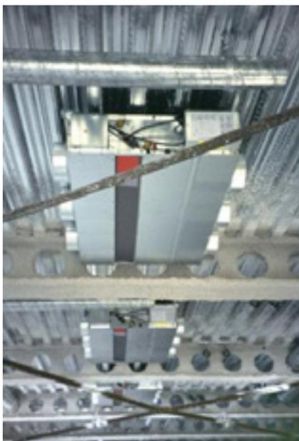
Рисунок 6.10. Горизонтальные инженерные коммуникации, проходящие через балки с перфорированными стенками
