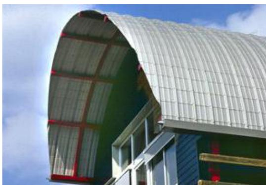
Рисунок 5.15. Арочное покрытие с оцинкованными стальными листами
