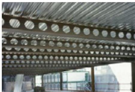
Рисунок 4.6. Новый тип балок – *Angelina™* (композитная балка) в процессе монтажа
