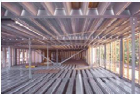
Рисунок 4.18. Фотография легкого перекрытия по профнастилу
