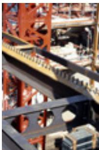
Рисунок 4.5. Композитная балка с перфорированной стенкой и стальным профнастилом
