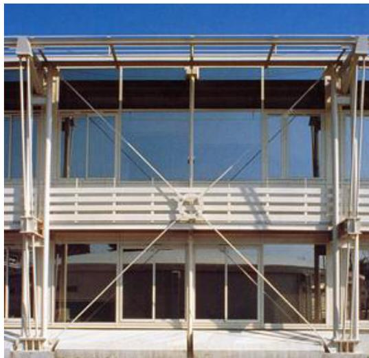
Рисунок 4.12. Поперечные связи, установленные снаружи многоэтажного здания
